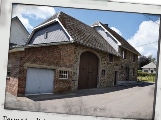
Ferme traditionnelle avec façade en pierres naturelles et une toiture à croupettes
