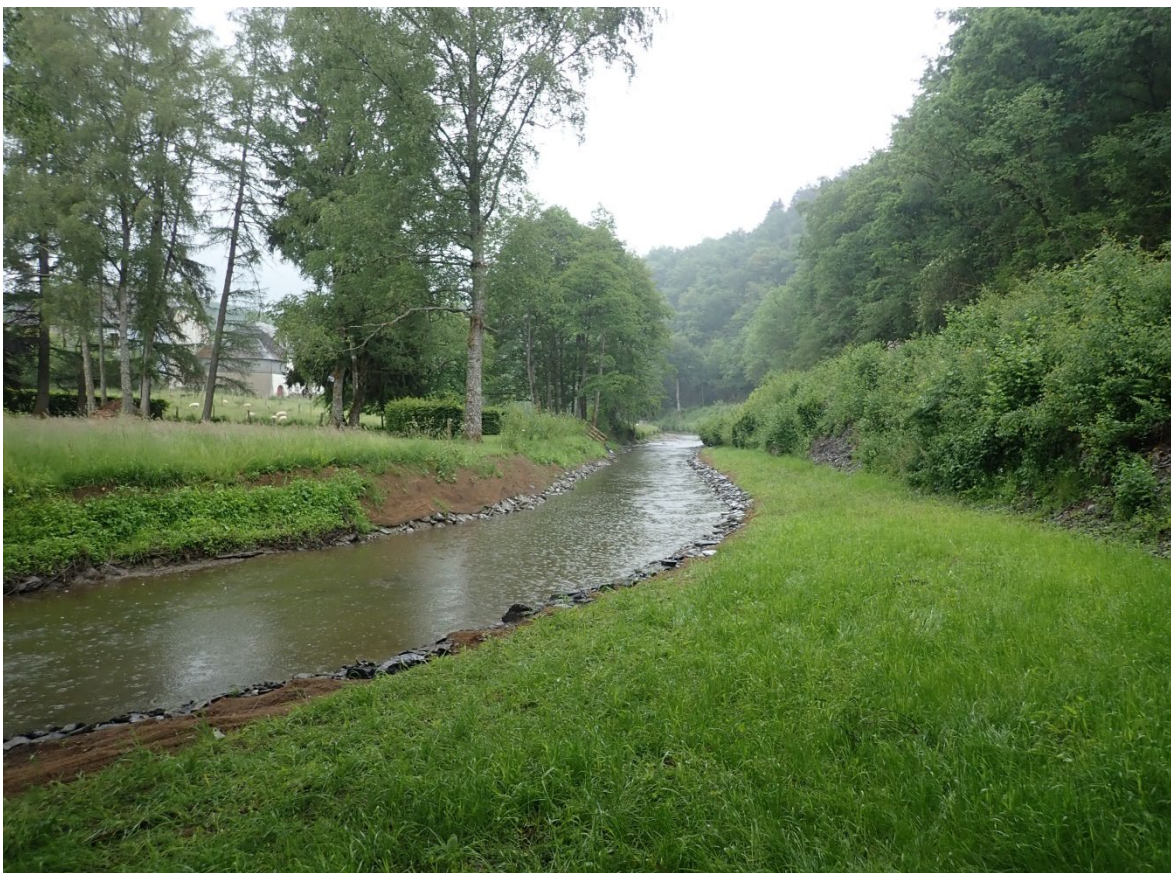
Vue générale du site, comparaison de la situation avant travaux et l'état après travaux
