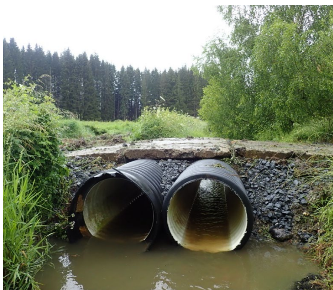
Panneau de chantier et passage provisoire installé sur la Sûre lors de la phase de préparation
