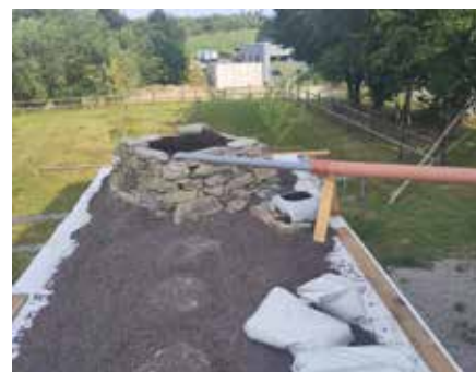
Aménagement d'un toit végétalisé
