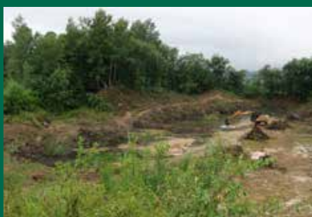
Terrassement en cours
