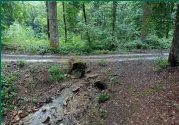
Affluent du Robais côté amont
